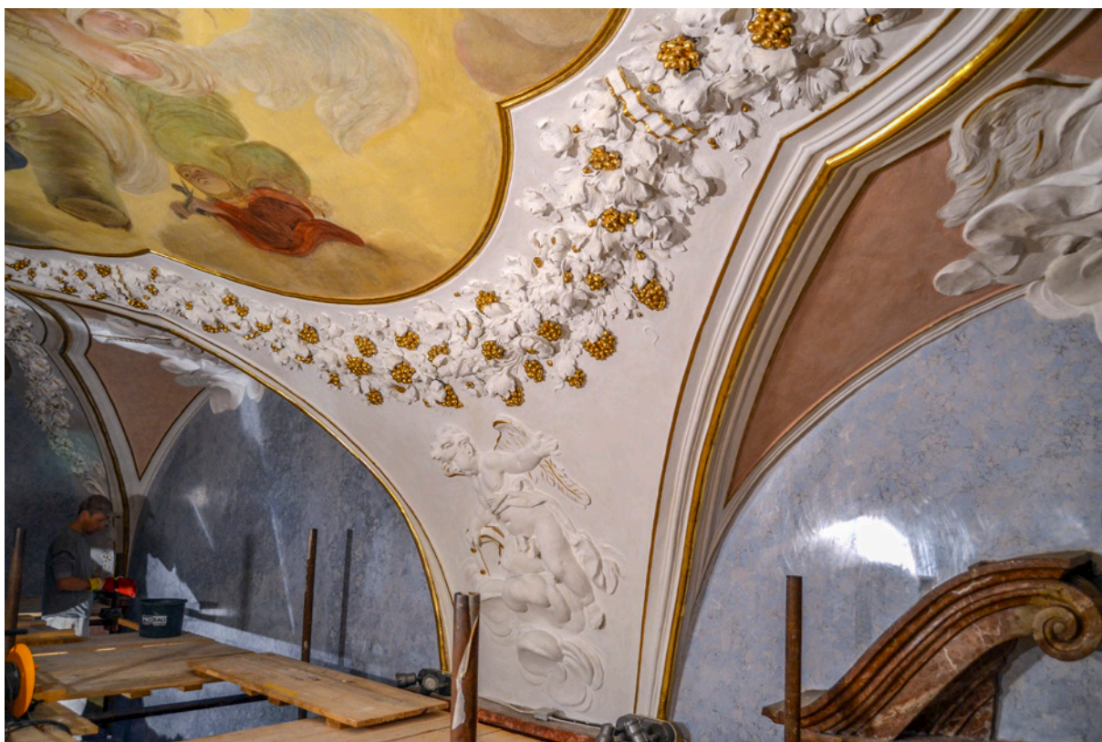
Výsek štukové výzdoby klenebního náběhu kaple sv. Ignáce (stav po restaurování)
