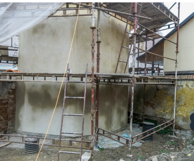
Vápenná jádrová omítka vnějšího pláště
