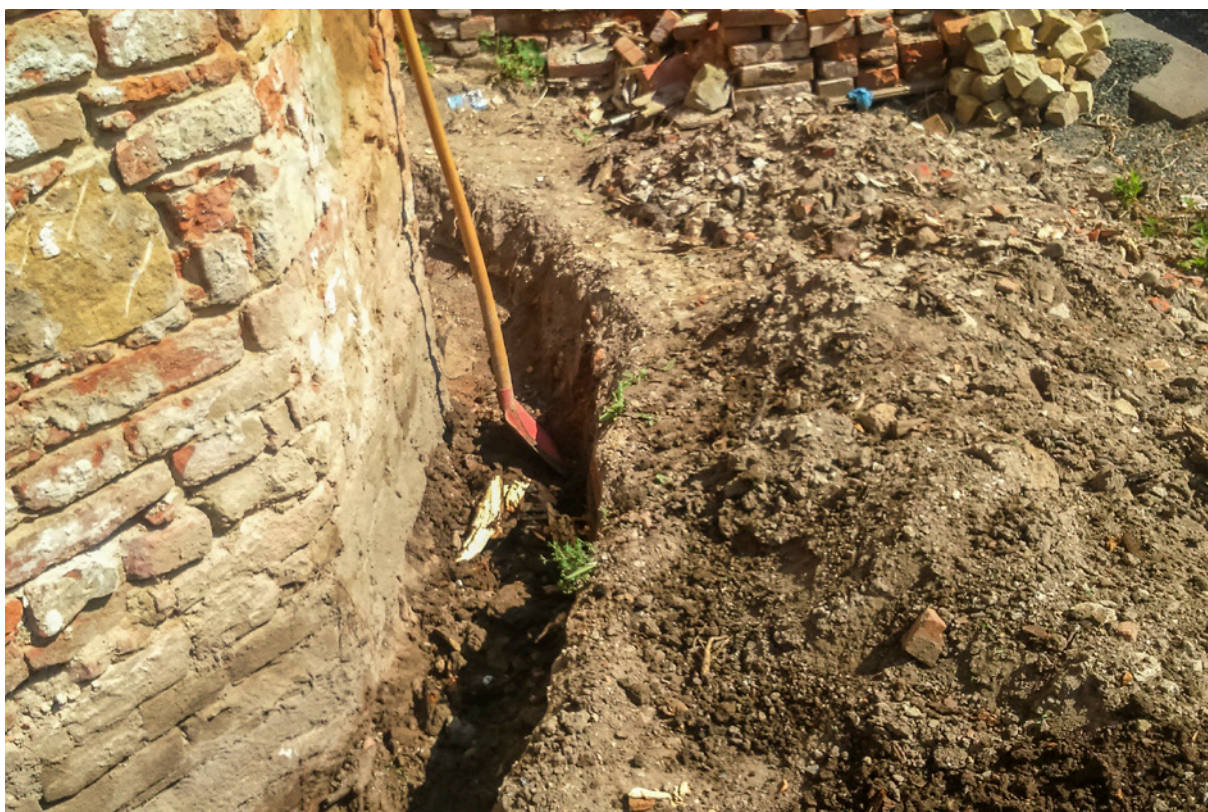
Odkryté základy vnějšího pláště kaple
