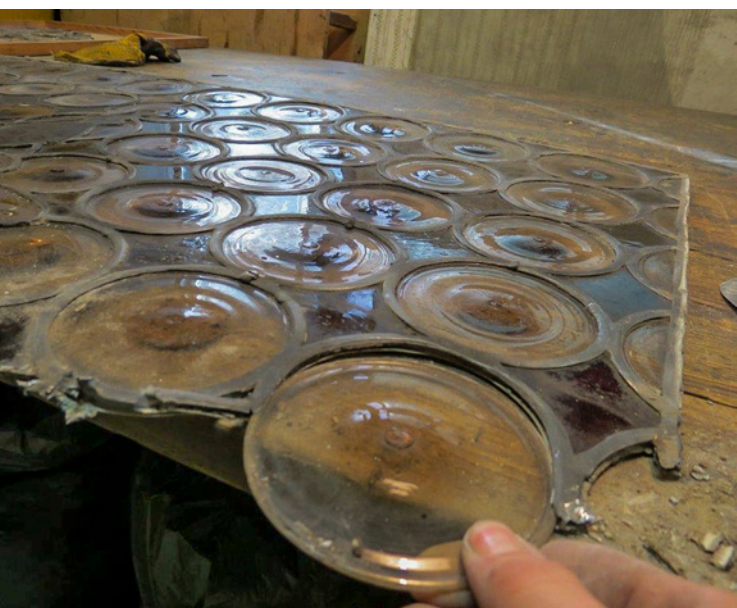
Vyjímání skleněných segmentů z olověné sítě
