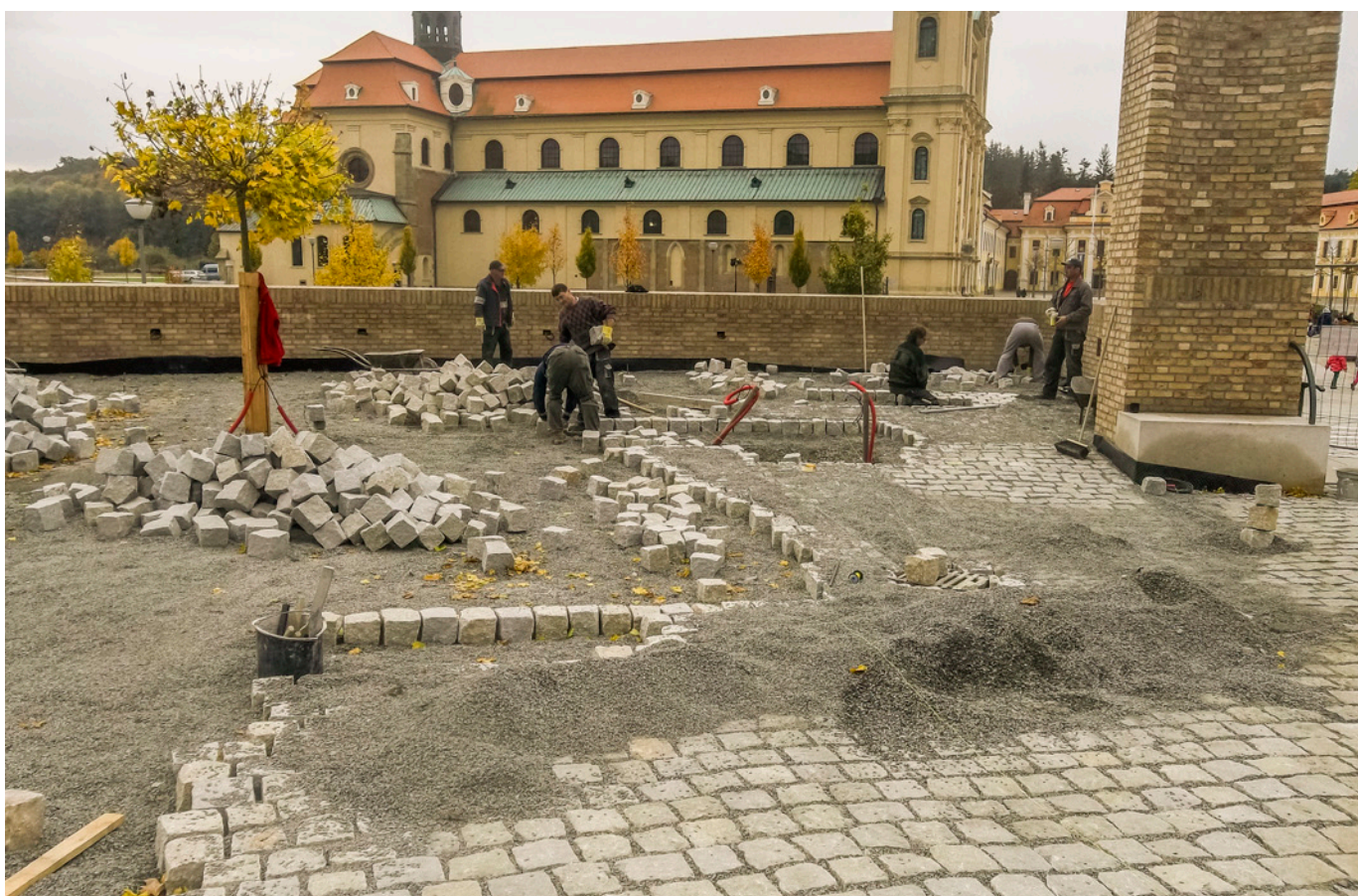
Dlážďení ploch hlavního vstupu do areálu
