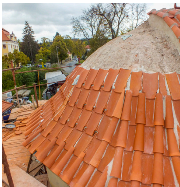
Detail kladení krytiny střechy a attiky
