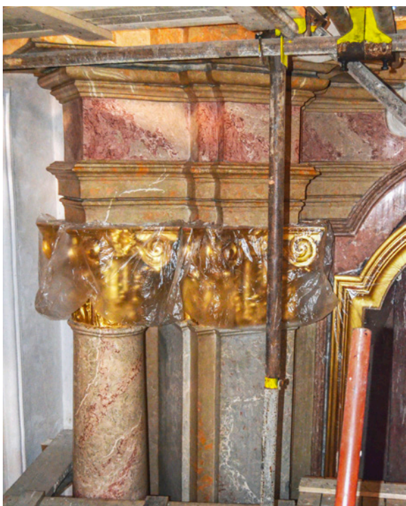
Horní část sloupového retáblu s římsou (před restaurováním)
