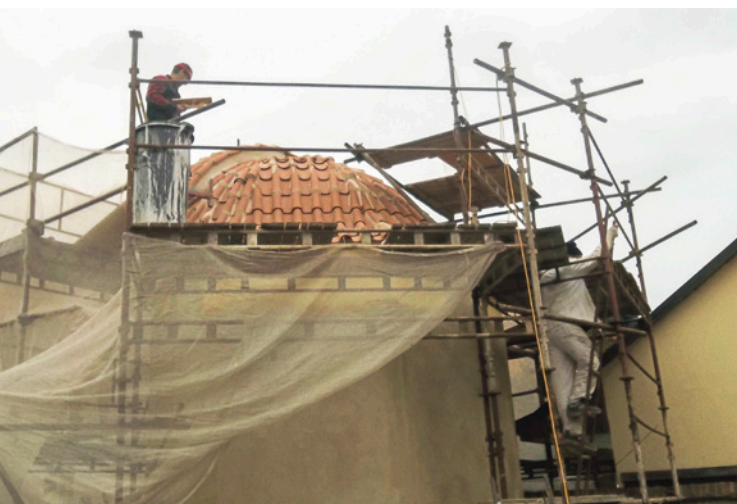
Pokládání prejzové krytiny na klenbovou střechu kaple
