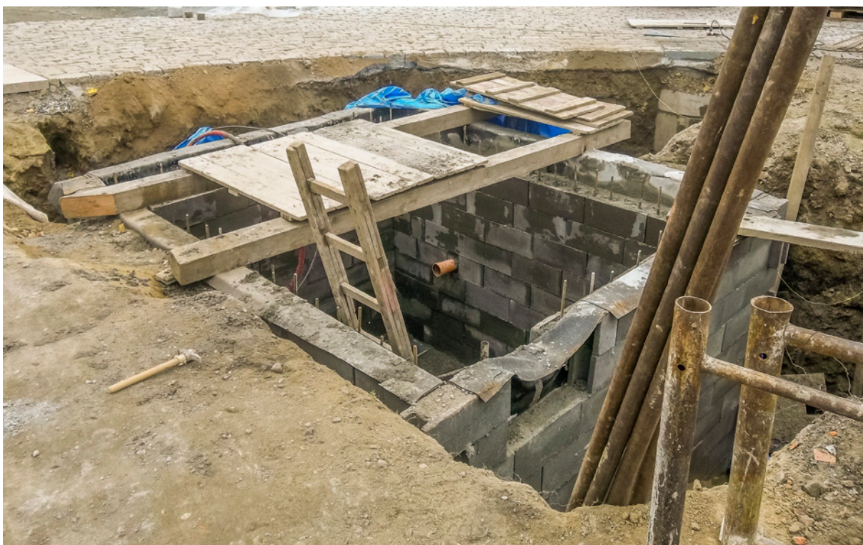
Konstrukce jímky pro technologii kašny
