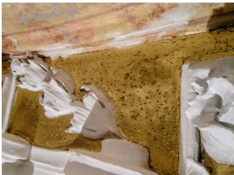
Detail poškození zlaceného povrchu
