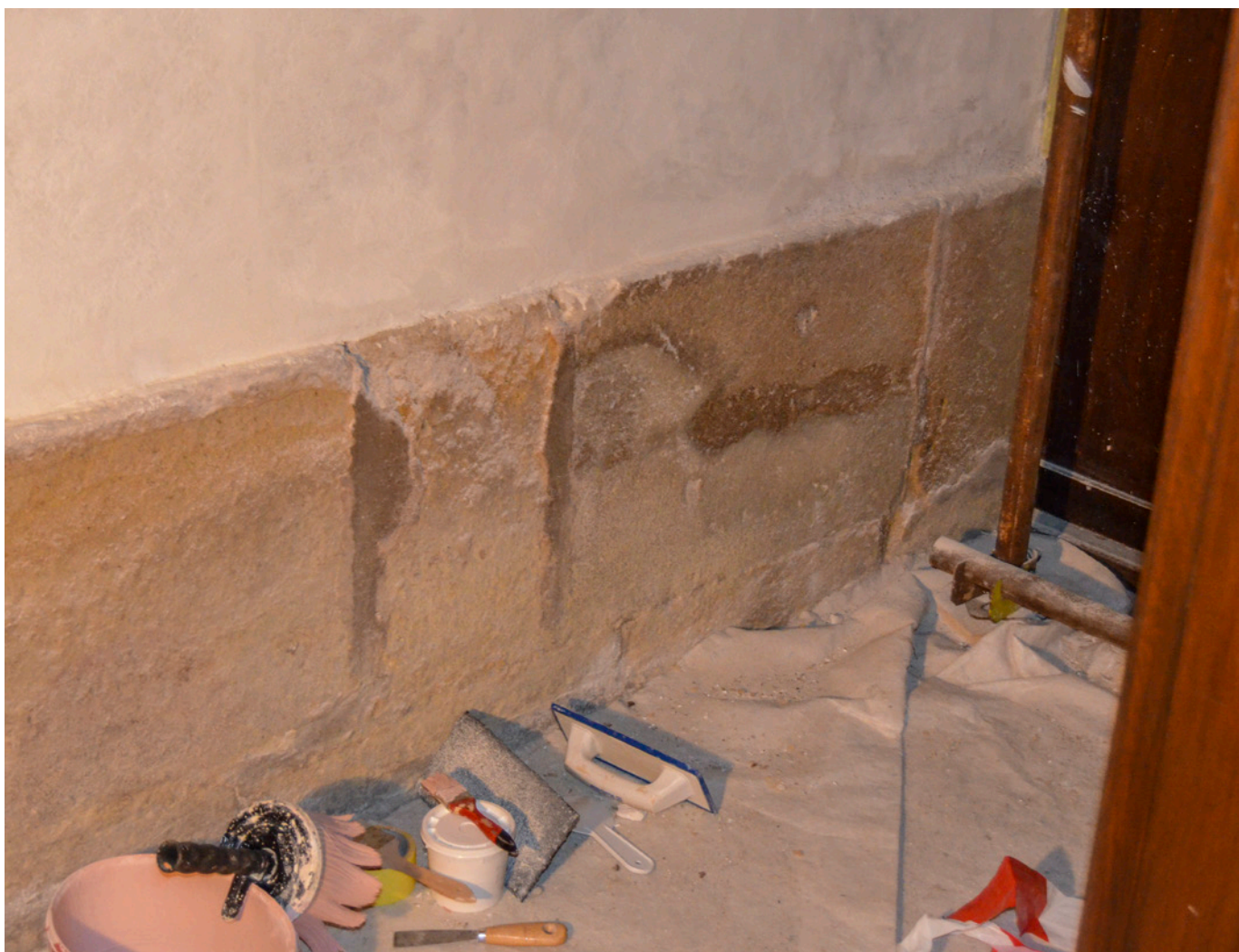
Degradované části pískovcového soklu
