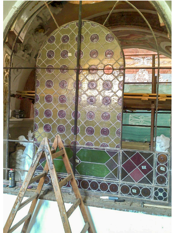
Demontáž vitráže Prázdný rám vitráže
