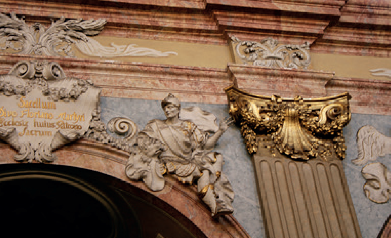
Pohled na původní stav štukového dekoru průčelí bočních kaplí
