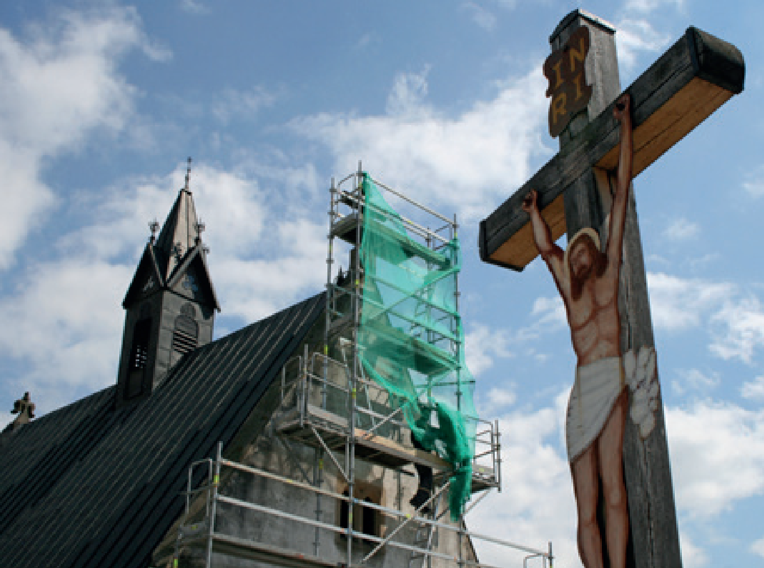
Poutní kostelík Zjevení Páně (Cyrilka) – v průběhu oprav
