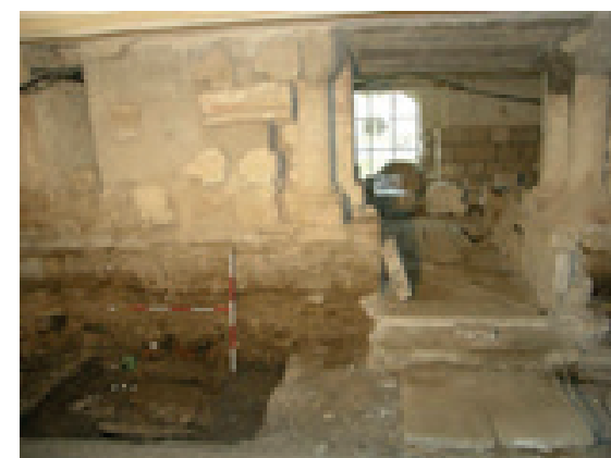
Stavební práce v Kapitulní síni lapidária
