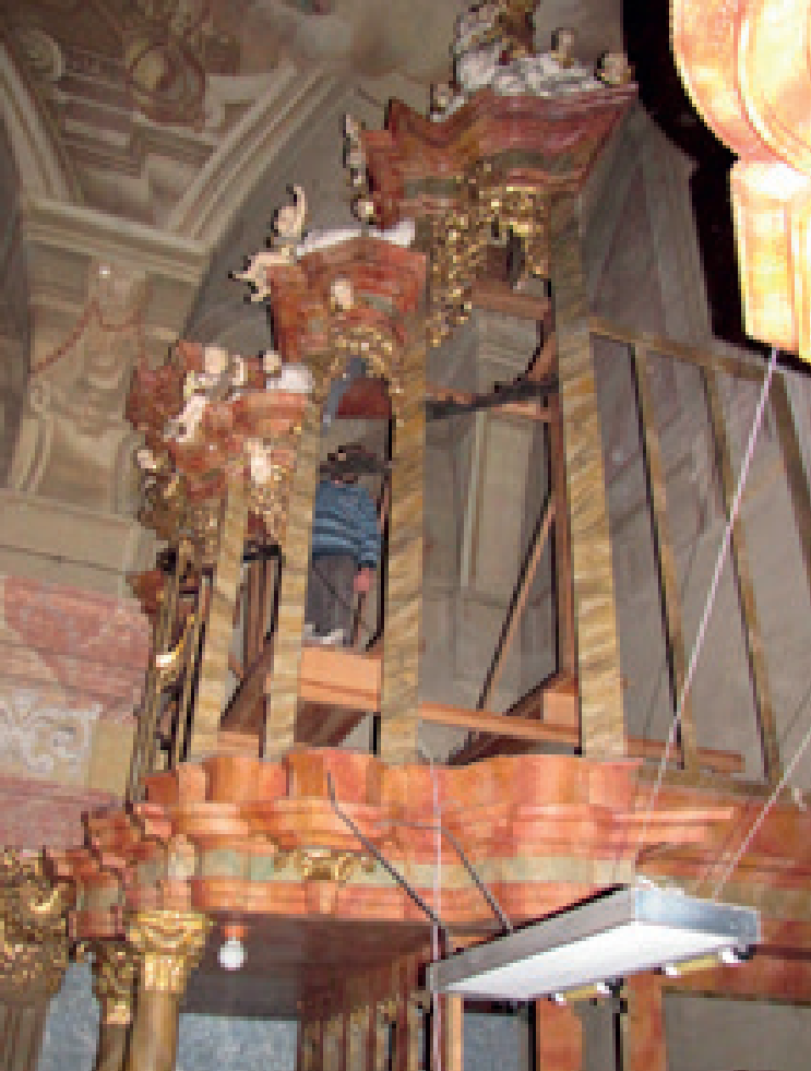
Demontáž varhan před generální opravou
