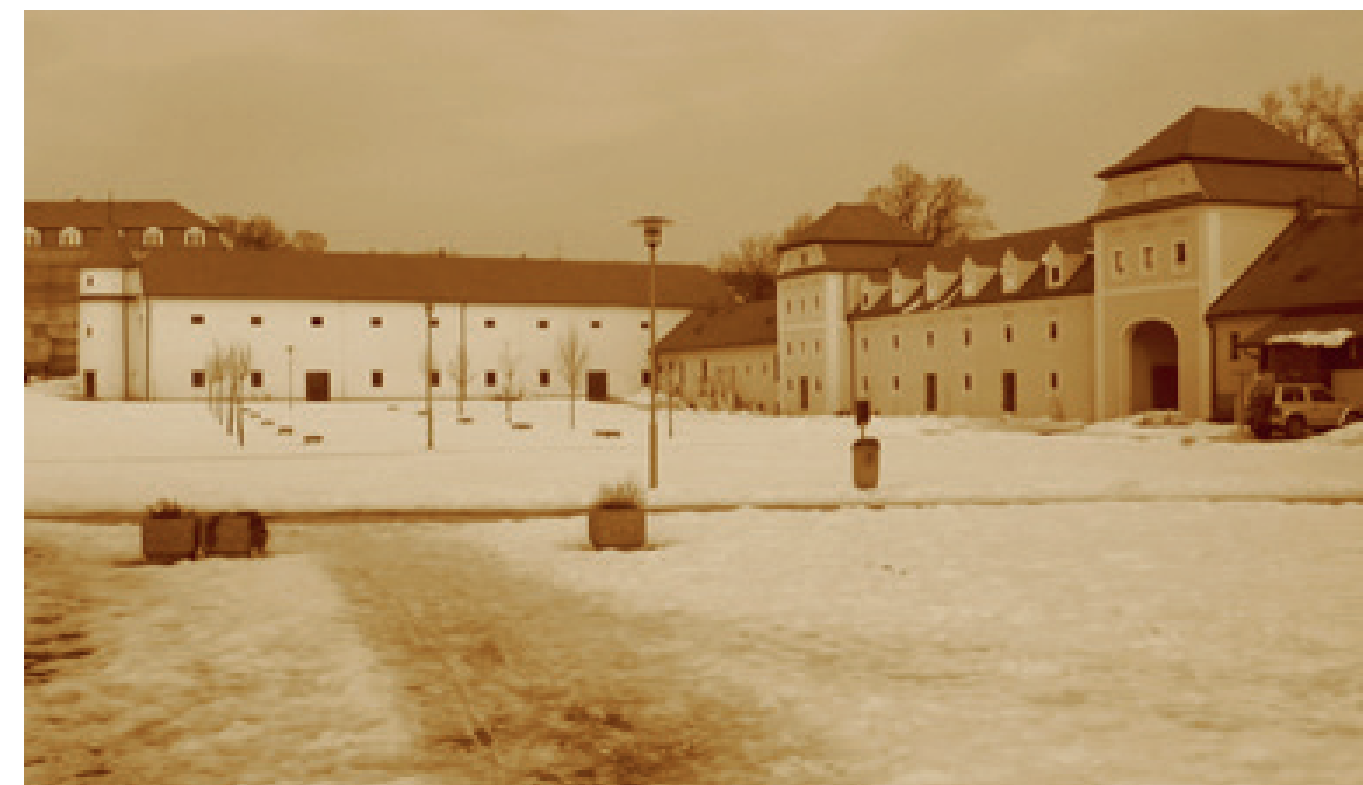
Pohled na jihozápadní průčelí sýpky a konírny – původní stav
