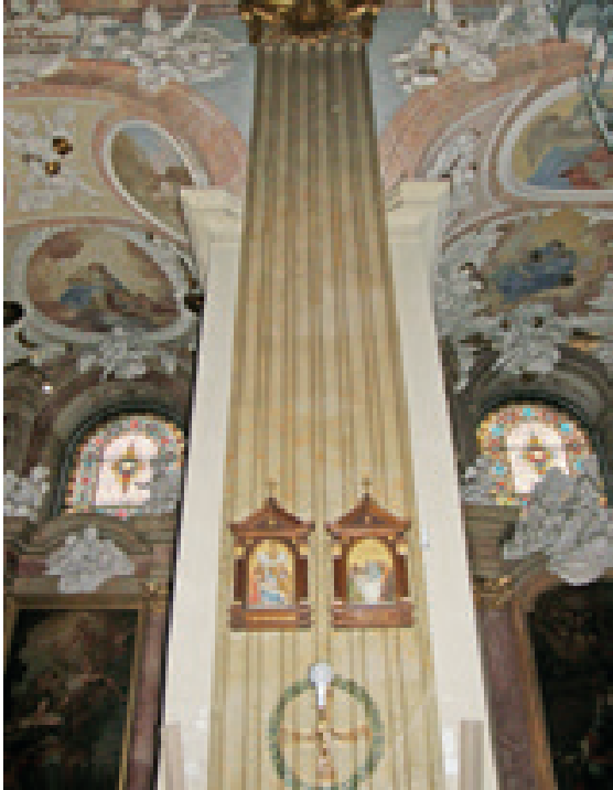
Dekor pilíře arkád kaplí, stav před restaurováním
