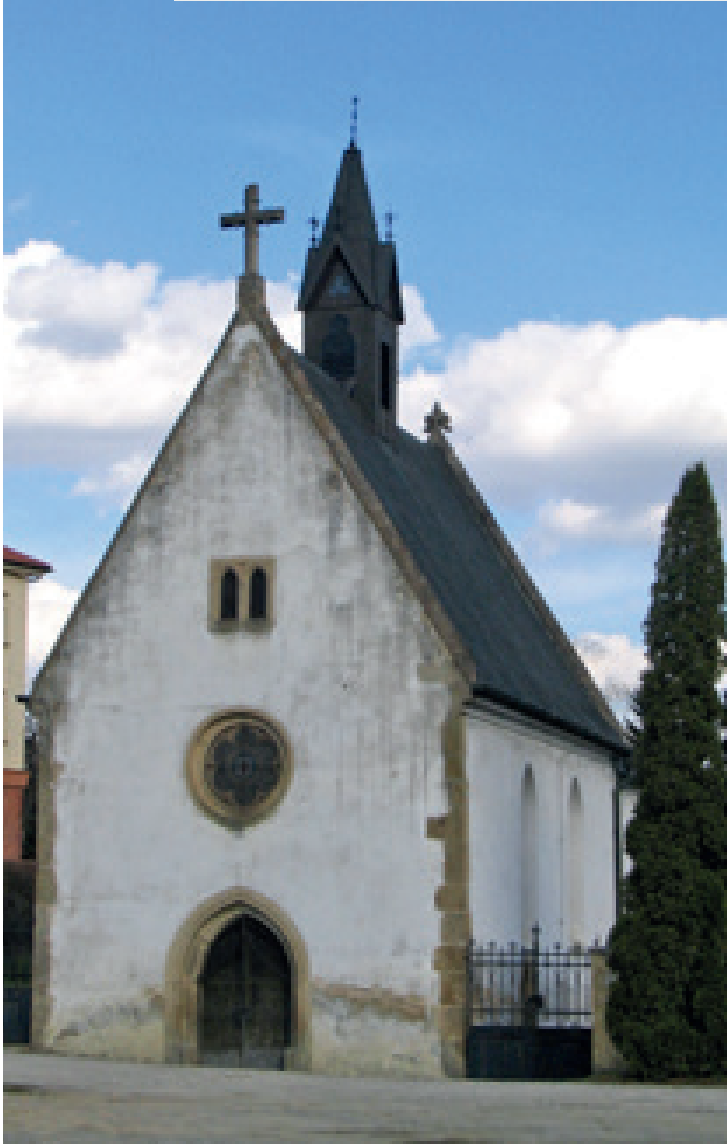
Průčelí kaple před rekonstrukcí
