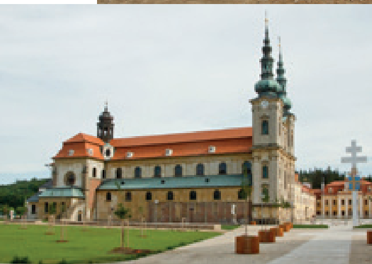
Plochy I. etapy po rekonstrukci. Stojanovo nádvoří
