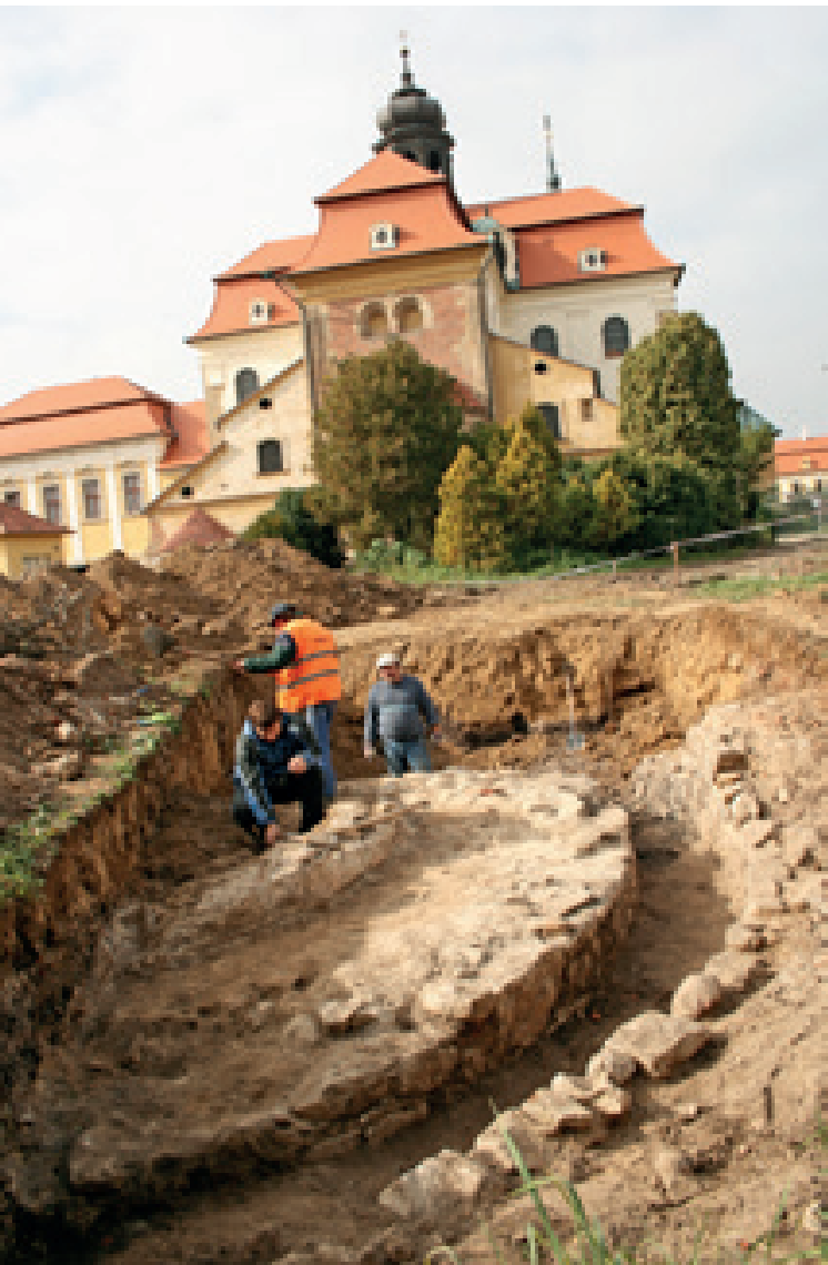
Základy kruhové strážní věže ohradní zdi kláštera
