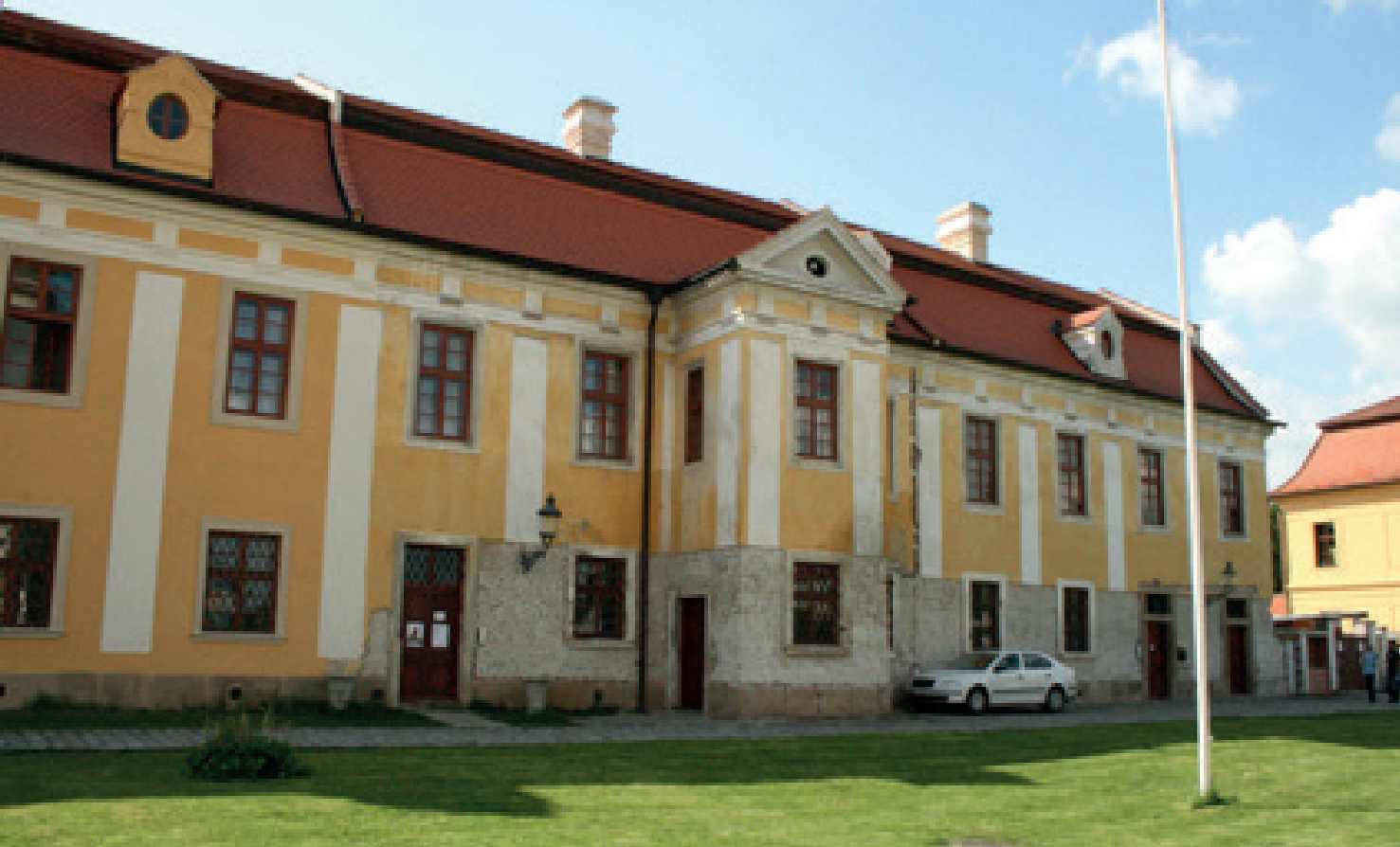
Budova velehradské fary před rekonstrukcí
