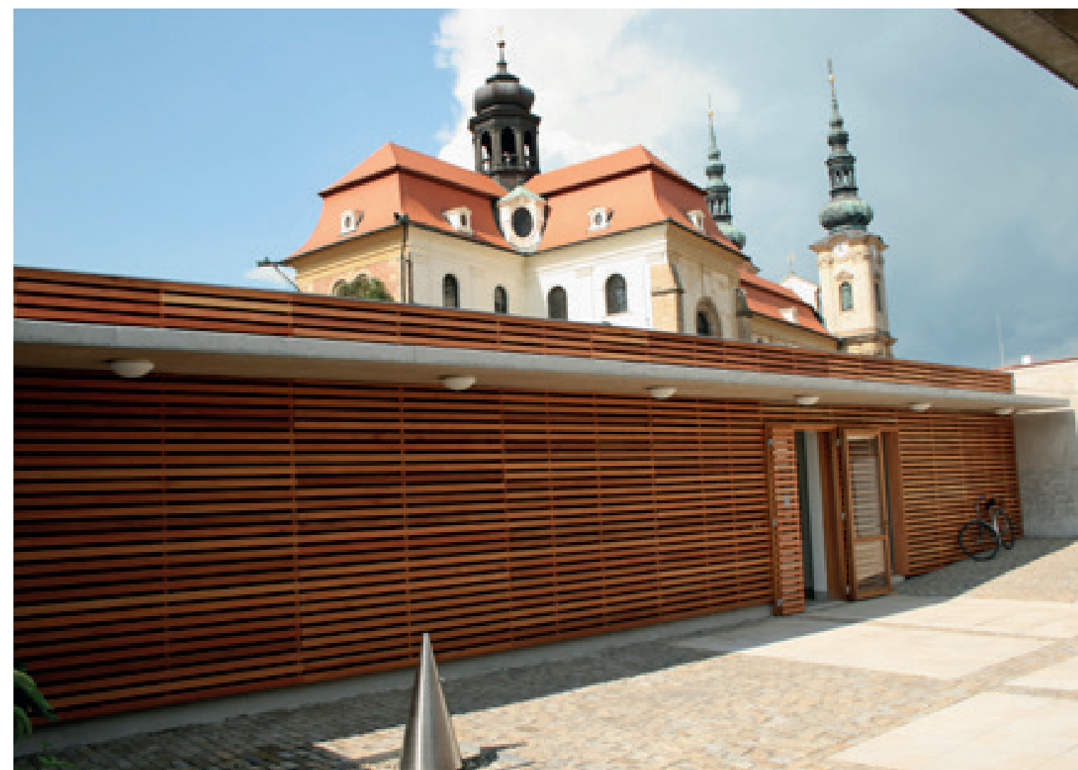
Nová budova veřejných WC
