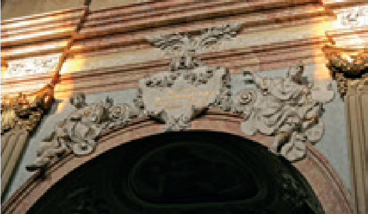
Štukový dekor průčelí arkád bočních kaplí s kartuší obsahující zlacený nápis zasvěcení kaple, stav před restaurováním
