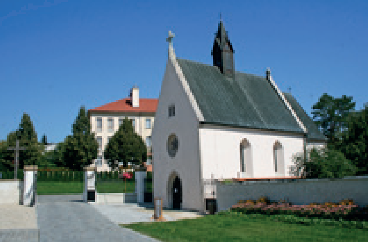
Kaple Zjevení Páně po rekonstrukci
