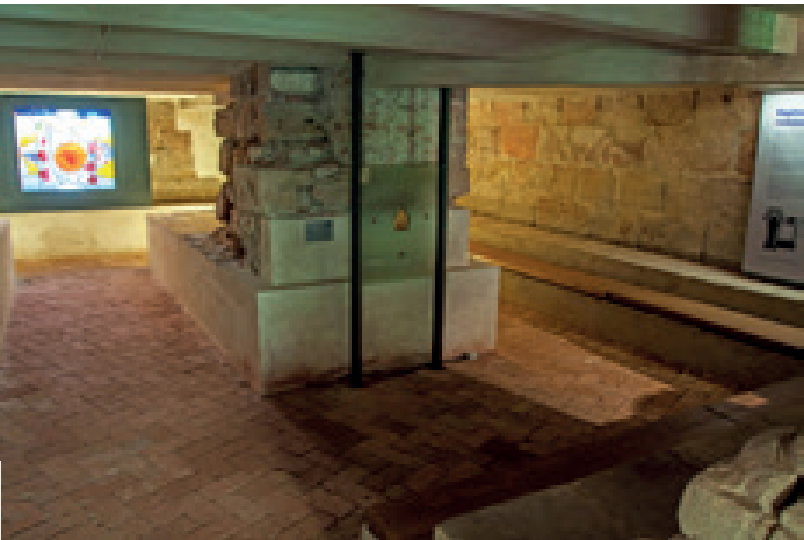
Stav Kapitulní síně po rekonstrukci
