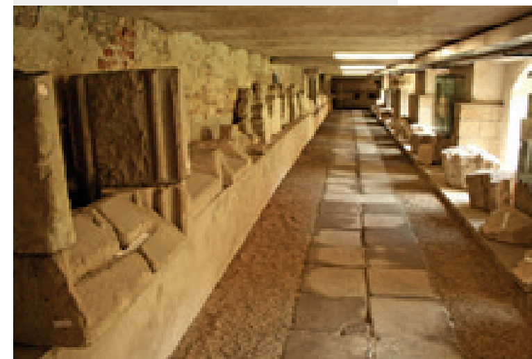
Stav křížové chodby lapidária před rekonstrukcí
